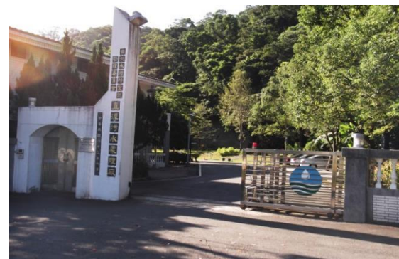
新北市 - 直潭污水處理廠
