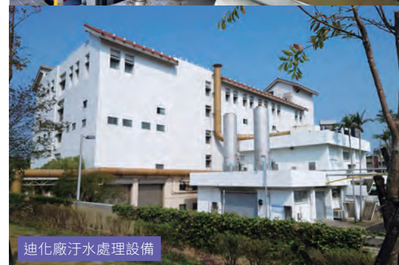
迪化汙水處理廠設備
