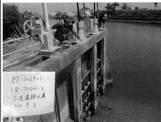
永隆溝排水溝 110.09.02
