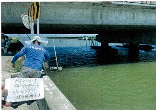
堤外線排水溝 113.06.27
