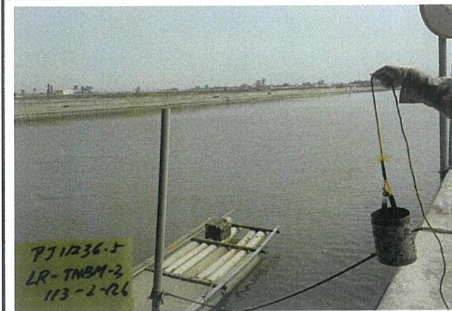
堤外線排水溝 113.02.26
