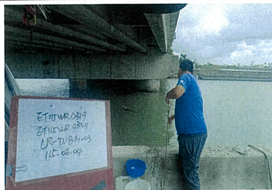
3堤外線排水溝
