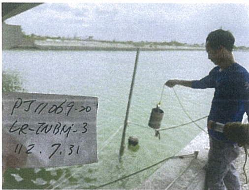
堤外線排水溝 112.07.31
