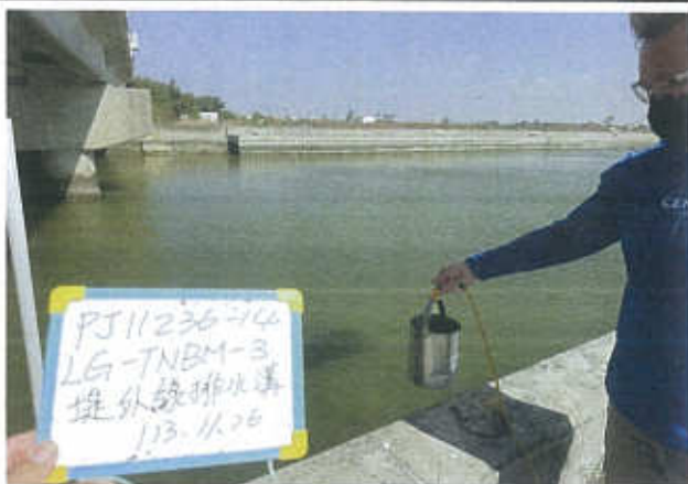
堤外線排水溝 113.11.26
