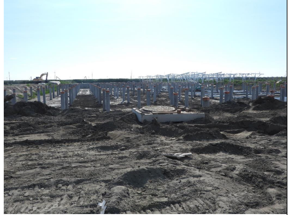
魚塭樣線 AS 環境照-已完成基樁正在架設鋼構之魚塭。 (拍攝日期 111 年 06 月)
