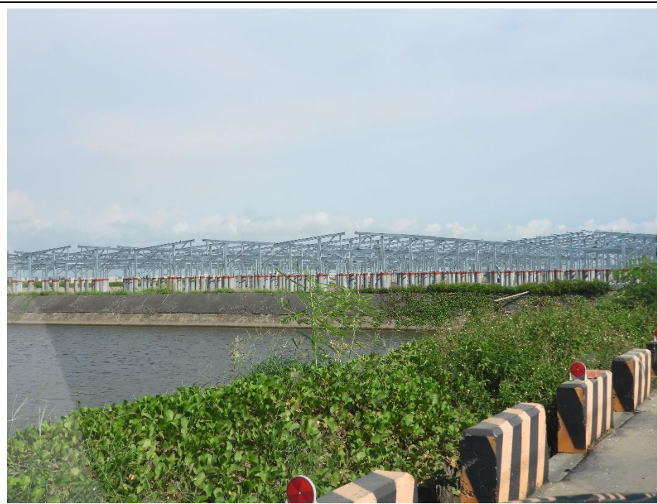
魚塭樣線 AS 環境照- 鋼構架設完成之魚塭。 (拍攝日期 111 年 06 月)
