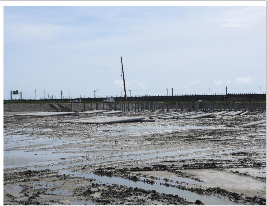
魚塭樣線 ES 環境照- 正在立樁之魚塭，未立樁部分呈潮濕灘地 樣態，適合鷓鴣類利用。(拍攝日期 111 年 05 月)
