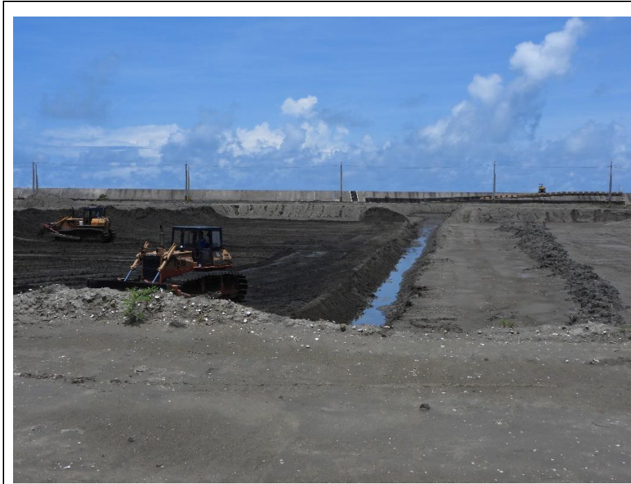
魚塢樣線 AS 環境照-本處魚塢正在整地，可見推土機在案場推平塢底、加厚岸堤，案場中間預留一條淺溝(拍攝日期 111 年 05 月)
